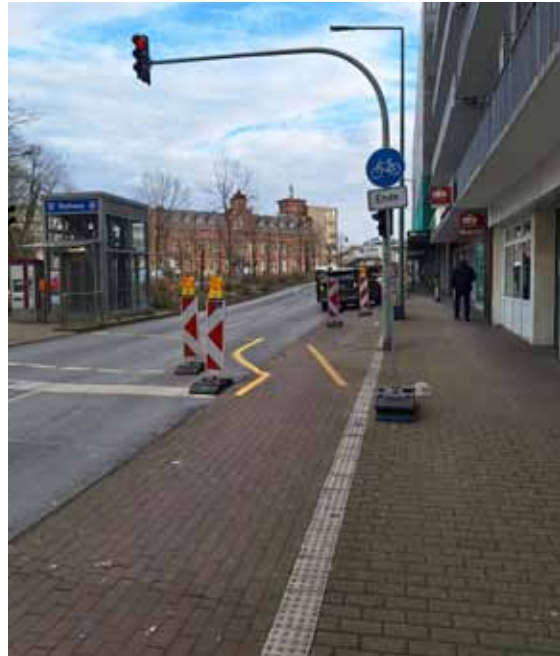
Geschafft! Die Schwanenstraße mit rechtskonformer Baustellensicherung
